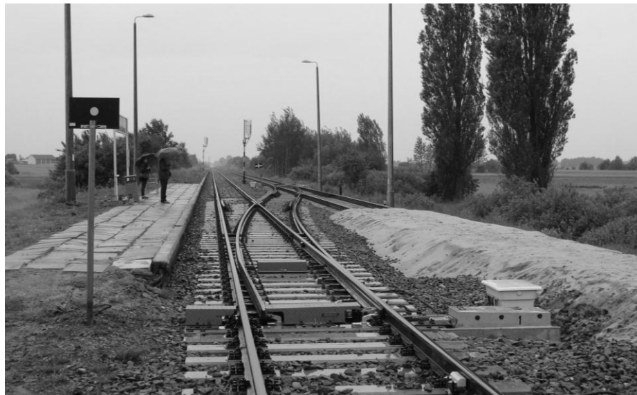
• Brzeźnica Bychawska między Parczewem a Lubartowem – nowa mijanka zbudowana w celu zwiększenia przepustowości ciągu objazdowego linii Warszawa – Lublin.
