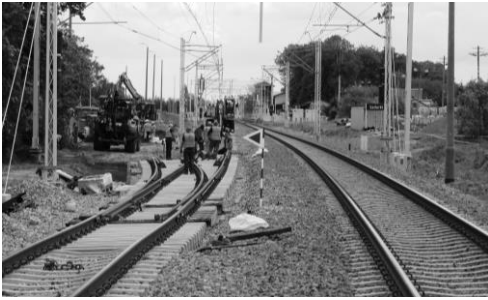
• Odbudowa stacji Sadurki na magistrali Warszawa – Lublin, koniec maja 2022 r.
