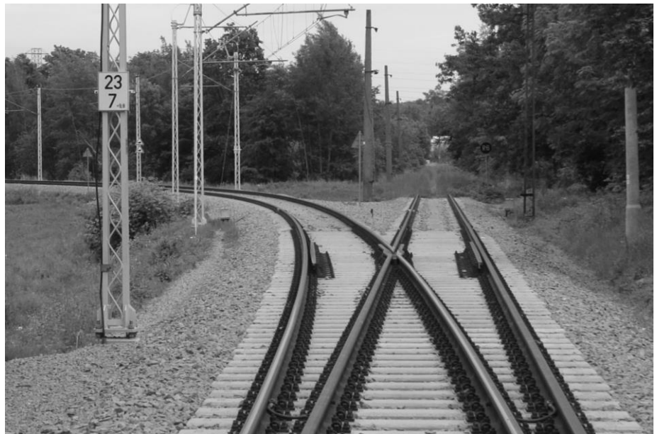
• Zachowane po modernizacji odgałęzienie w Skoczowie na nieczynną linię do Bielska-Białej.
