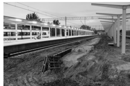
• „Modernizacja linii Warszawa – Poznań to lekcja do odrobienia” – mówi Malepszak. Stacja Kutno w trakcie przebudowy, 2020 r.
