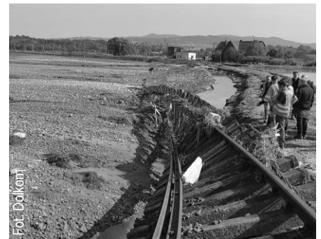
• Do największych zniszczeń infrastruktury kolejowej doszło w Kłodzku. Wylot linii do Kudowy-Zdroju po przejściu wielkiej wody.
