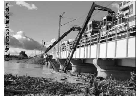
• Kolejarze, usuwając drzewa niesione przez wezbraną Nysę Kłodzką, chronią przed zniszczeniem most linii Wrocław – Opole w Lewinie Brzeskim.
