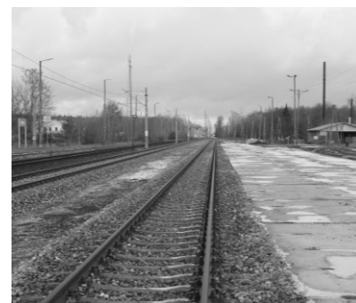
• Na dawnej stacji Dalekie odbudowano dwa tory boczne, powstał również plac ładunkowy.
