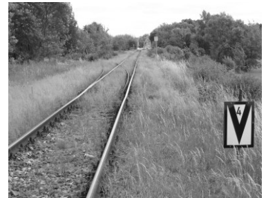
• Wskaźnik ograniczenia prędkości do 40 km/h na dawnej stacji Gucin na linii Ostrołęka – Małkinia.
