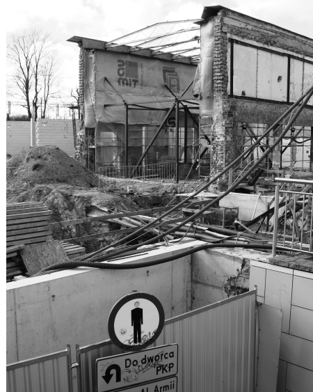
• Nowy dworzec kolejowy w Koszalinie miał zostać otwarty pod koniec 2024 r. Stan budowy w marcu 2025 r.
