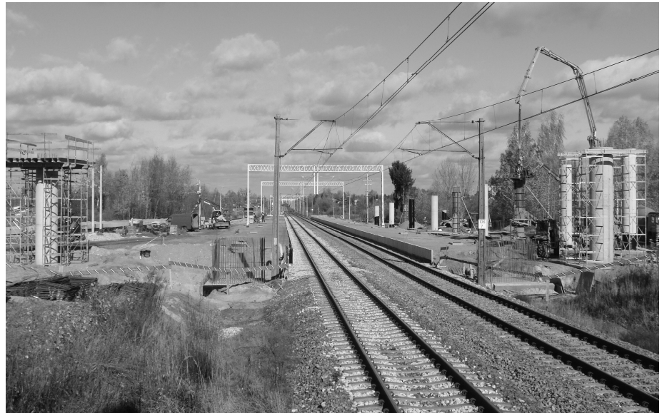
• Budowa przystanku kolejowego na Osiedlu Południe w Radomiu.
