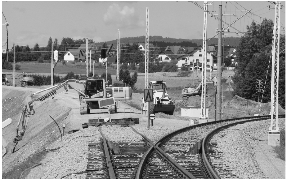
• Łącznica omijająca stację Chabówka w trakcie budowy w sierpniu 2023 r.
