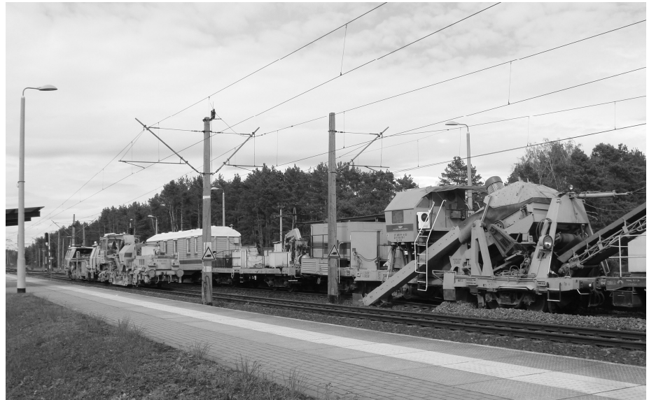
• Prace na linii Tłuszcz – Wyszaków – Ostrołęka mają potrwać do grudnia 2026 r. Maszyny torowe na stacji Mostówka.
