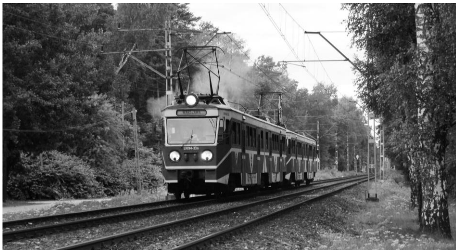
• Urząd Transportu Kolejowego wskazał 61 miejsc, gdzie drzewa rosną zbyt blisko torów linii WKD i nakazał ich wycinkę. Nielegalne drzewa między Otrębusami i Podkową Leśną.
