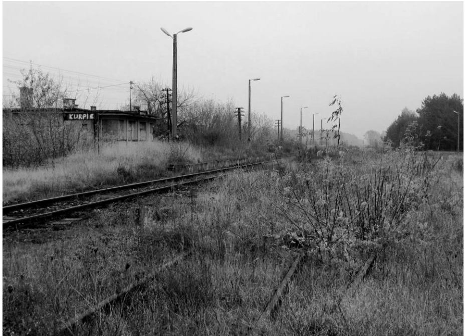
• Zapomniana stacja Kurpie na linii Ostrołęka – Łapy. Tędy ma przebiec jeden z alternatywnych ciągów na czas drugiego etapu modernizacji linii Warszawa - Białystok.
